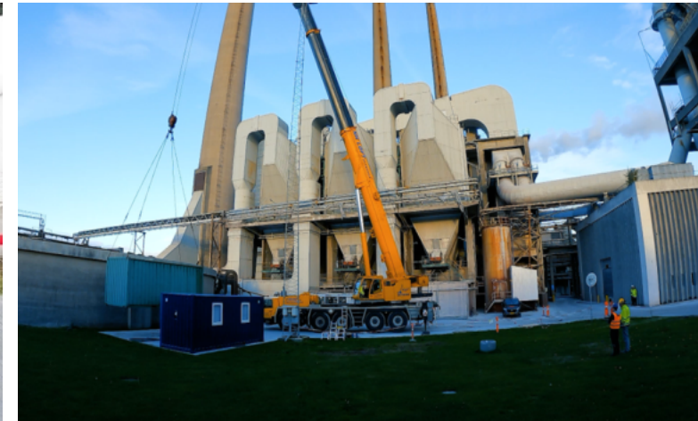
Pilotanlægget skal teste forskellige procesteknologier til fangst af CO 2 fra røggasser i cementproduktion. Røggasserne kommer fra Aalborg Portlands største cementovn. Anlægget er ejet af DTU og har tidligere været opstillet hos Amager Ressource Center (ARC).
