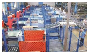
Inspección del sistema con selladoras de cajas de cartón, cargadores de paletas, envolvedoras de film, e integradas con el transporte de cajas de cartón y paletas. El sistema incluye un moderno sistema de control con integración en el sistema SAP del cliente.
