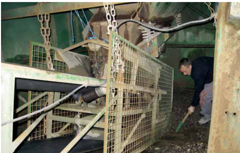
Tunge løft og dårlige pladsforhold.
