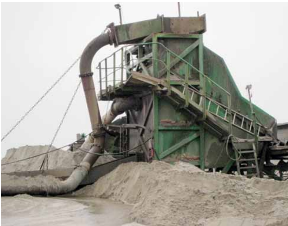
Platform forsynes med rækværk mod ulykkesfare.
