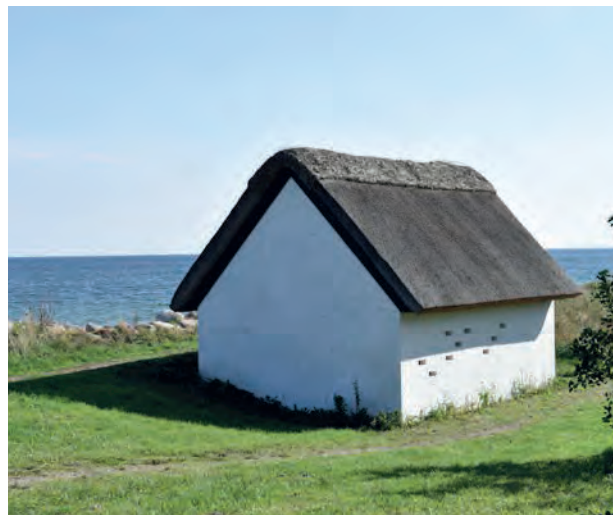
Foto 20 Lille hus – korte rør
