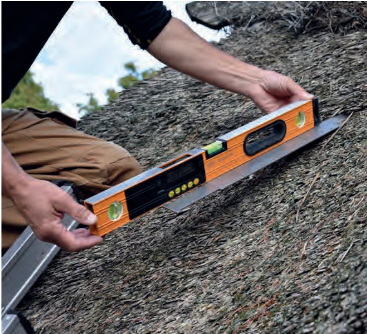
Foto 9 Måling af rørenes hældning
