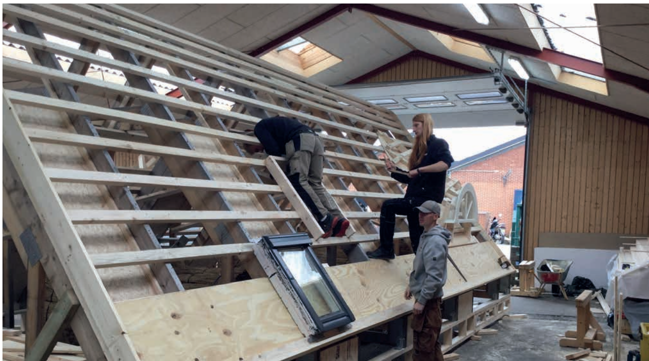
Foto 46 Tagkonstruktion lægtet til stråtag
