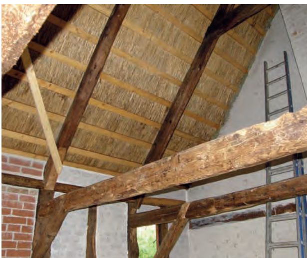
Foto 30 Brolag sikrer en pæn underside
