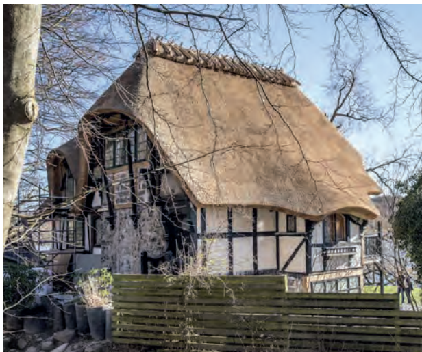
Foto 19 Stort hus – lange rør
