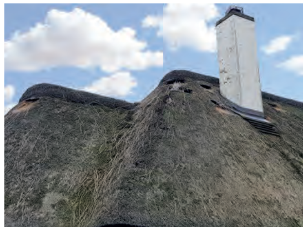
Foto 65 "Fugleskader"
