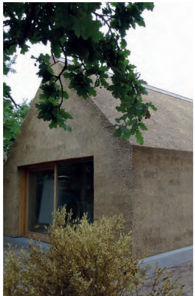
Foto 2 Tag og facade tækket ud i et
