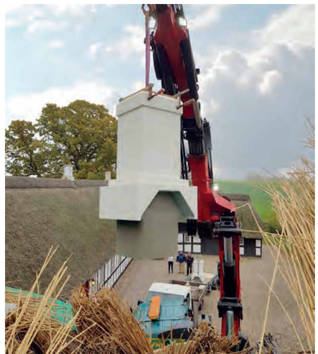
Foto 58 Opsætning af ny skorsten med udkrægning
