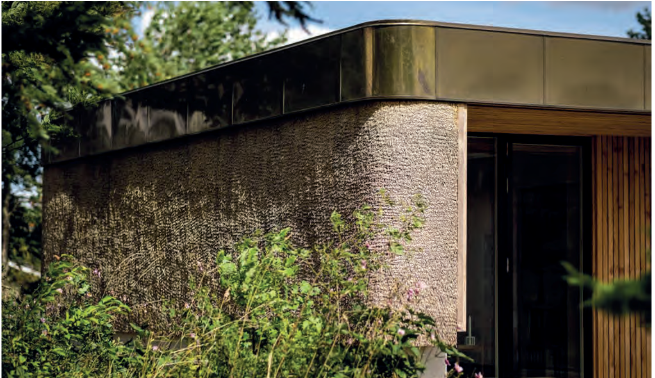
Foto 70 Tækning af lodret facade
