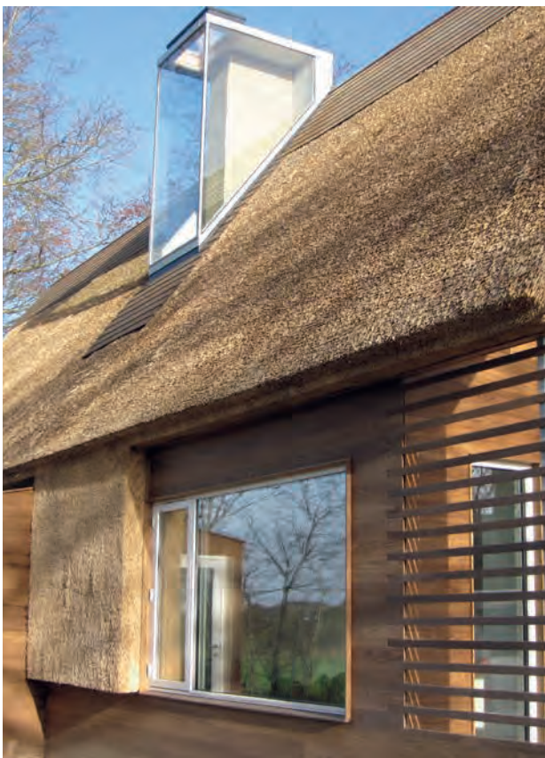
Foto 72 Lodret tækning – Det Åndbare Hus
