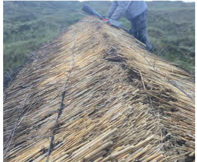
Foto 33 Rygning, der er klippet
