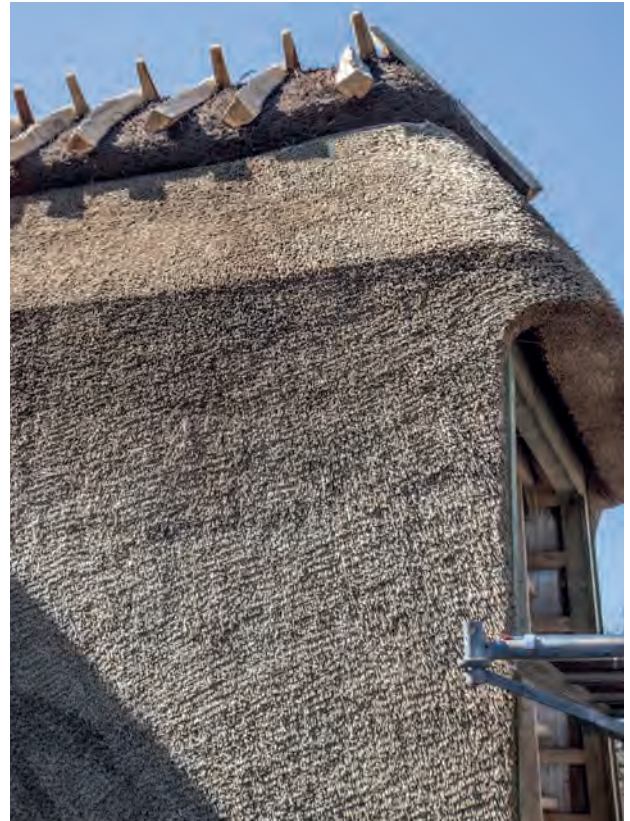
Foto 73 Tækning af mansardtag
