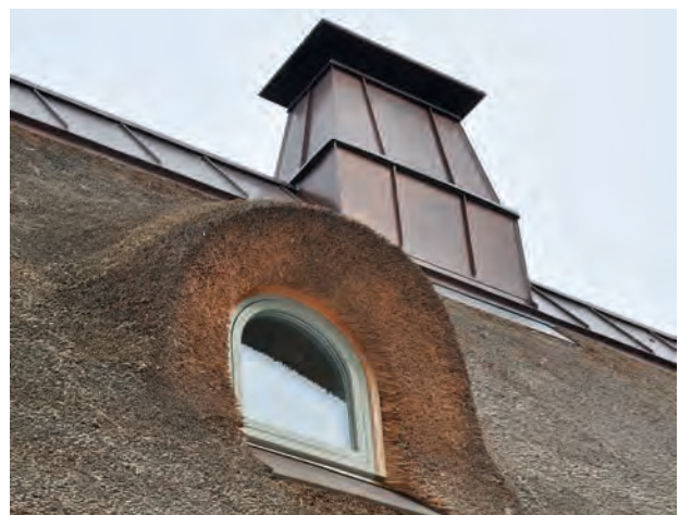
Foto 43 Fast kobberrygning
