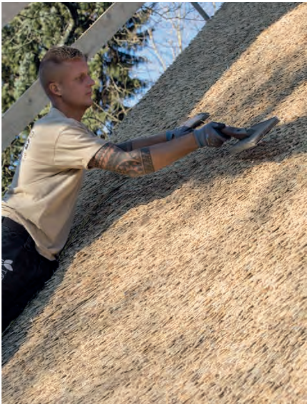
Foto 34 Tagfladen bankes på plads med en tækkeskovel
