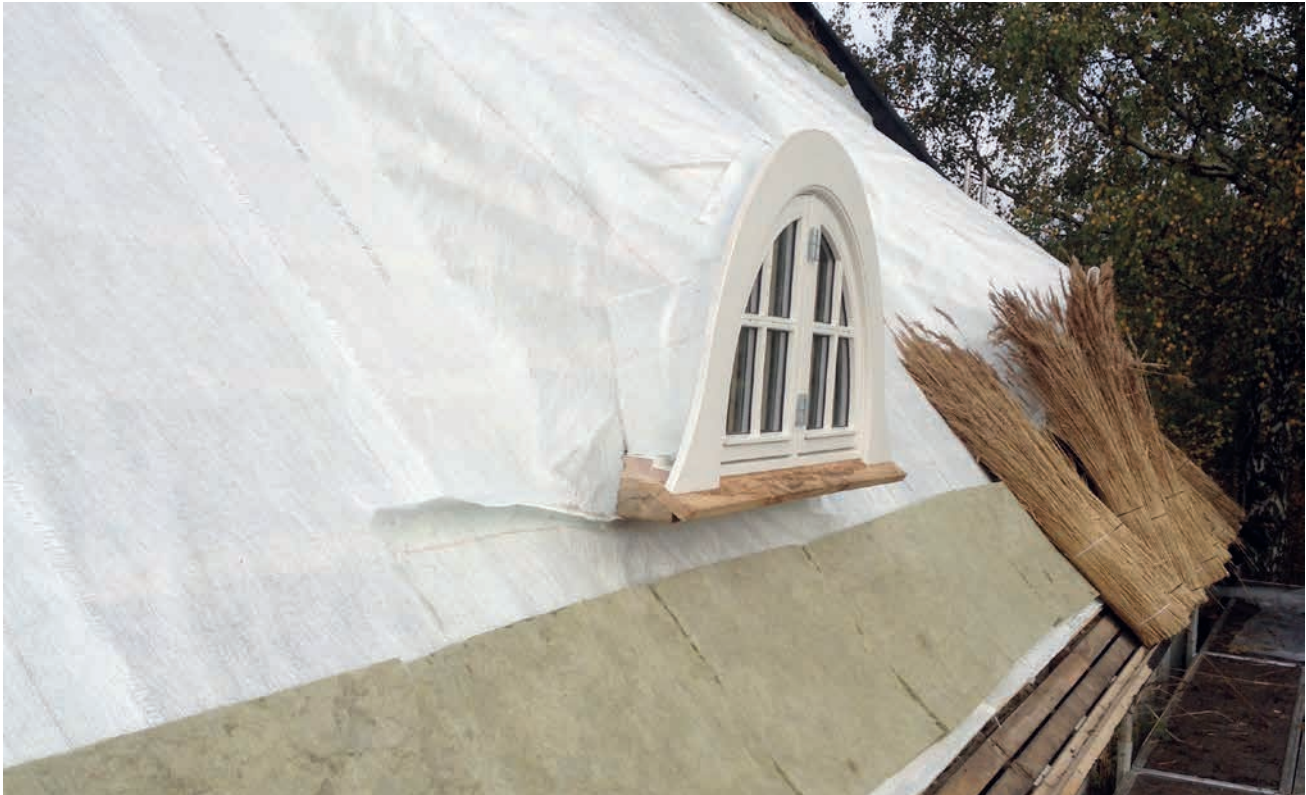
Foto 6 Brandsikring med godkendt glasfiberdug og kantisolering
