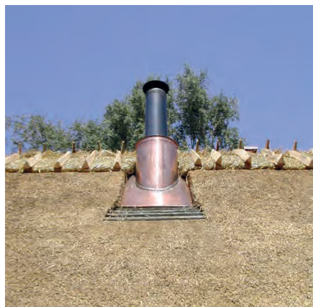
Foto 60 Kobberinddækket stålskorsten
