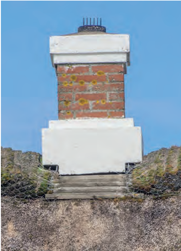
Foto 56 Skorsten med muret udkrægning
