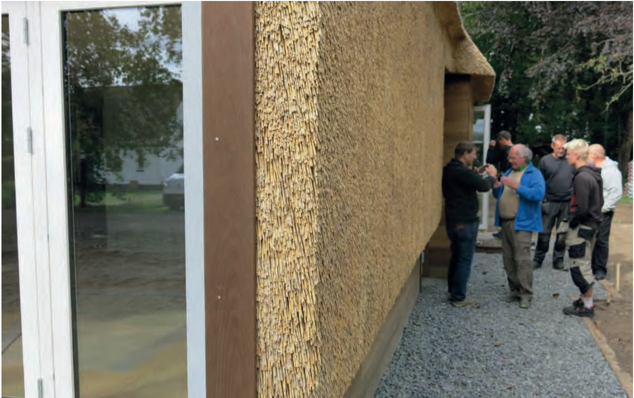
Foto 71 Lodret tækning – Det Åndbare Hus
