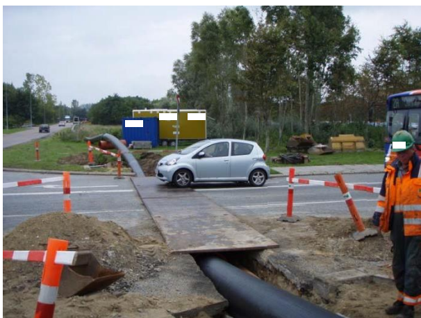
Foranstaltning af ekstra anlægsarbejder for oplæg af medierør forud for itrækning kan være nødvendige
