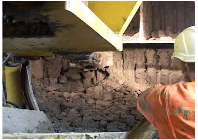
Udgravning ved rørfront
