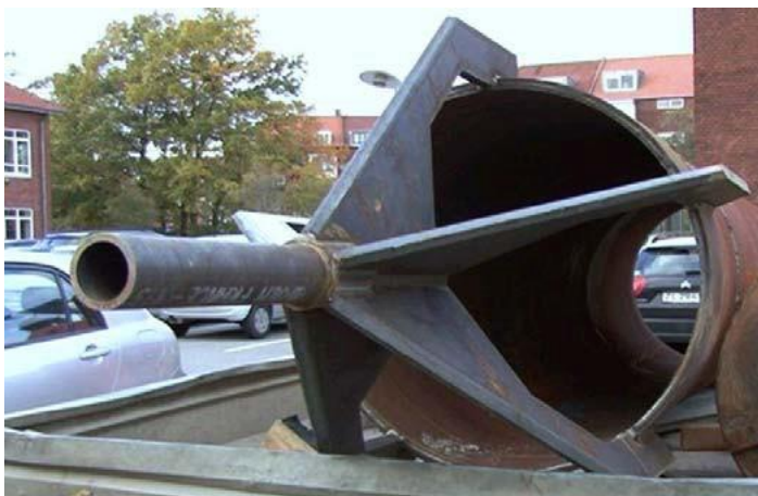
Sammensvejsning af stålør i pressegrube
