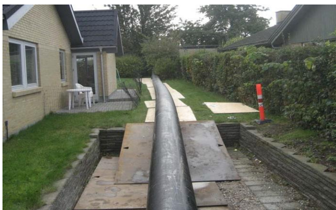
Oplægning af svejst PE-ledning forud for itrækning
