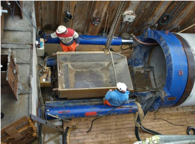
Typisk pressegrube for tunnelering
