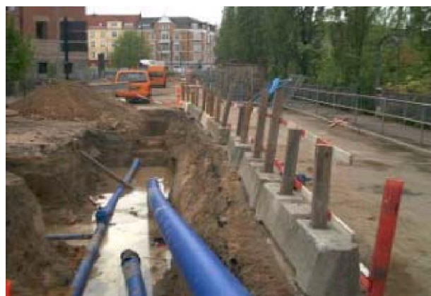
Itrækningsgrube for PE-rør oplægning af medierør
