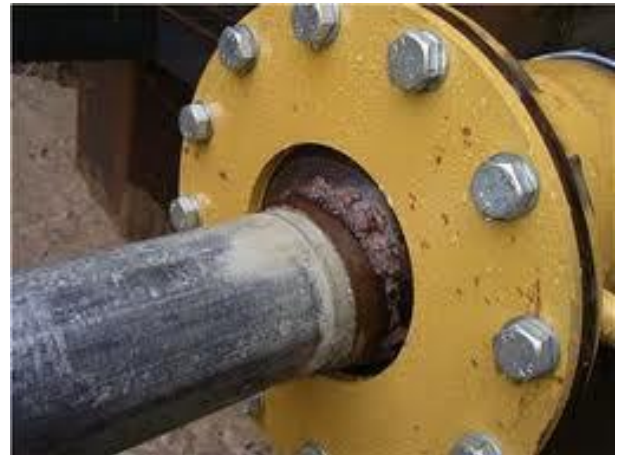
Iboring af pilotrør via flangetætning monteret på byggegrubens væg
