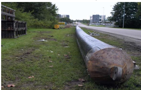
PE-rør monteret med trækhoved klar til itrækning
