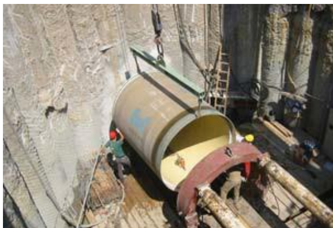
Ipresning af GAP-rør
