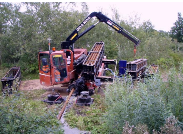
Borerig under ipresning/-boring af borestænger
