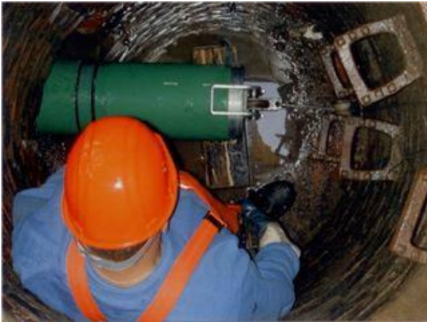
Montering af klikrør fra eksisterende brønd
