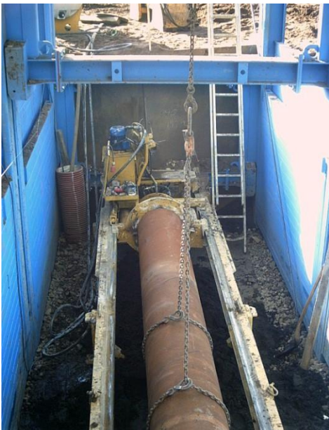
Stålrør under ipresning
