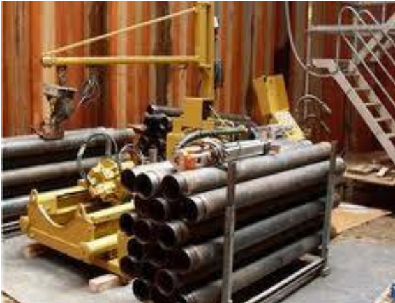
Pilotrør klar til iboring
