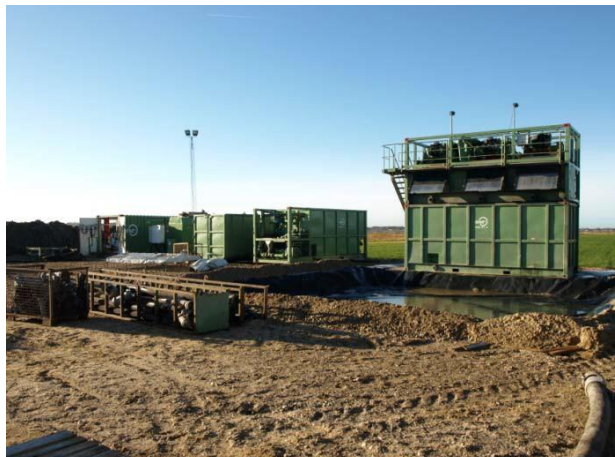
Større mobilt separationsanlæg anvendt ved krydsning af Limfjorden med 2 stk. Ø400 mm ledninger
