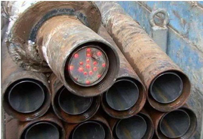
Borehoved med optisk lysgiver- også kaldet målskiven. Nederst pilotrør. Lyset fra målskiven bag borehovedet skal være synlig fra afsendegruben under hele boringen.
