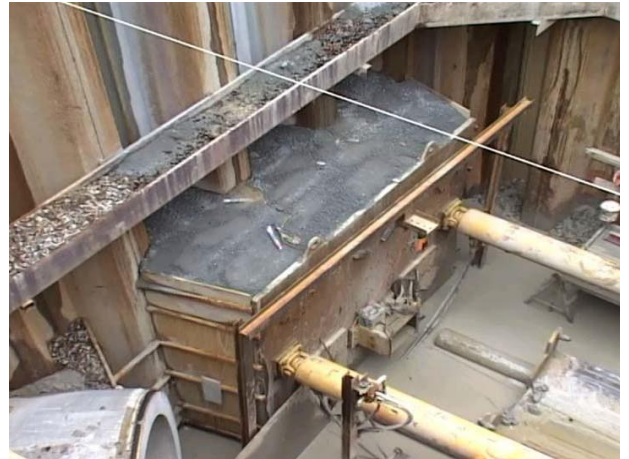
Modhold for presserig. Modholdet skal kunne modstå et pressetryk på op til 1.600 ton
