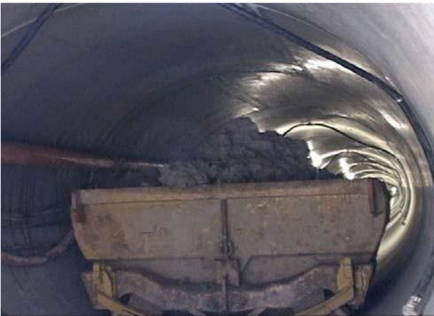
Transport af jord fra rørfront til pressegrube i jordvogn. Bemærk den sorte injektionslange langs rørets periferi for injektion af boremudder
