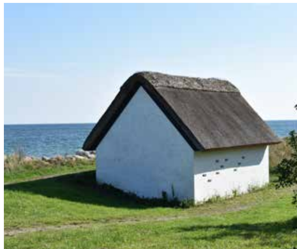
Foto 20 Lille hus – korte rør
