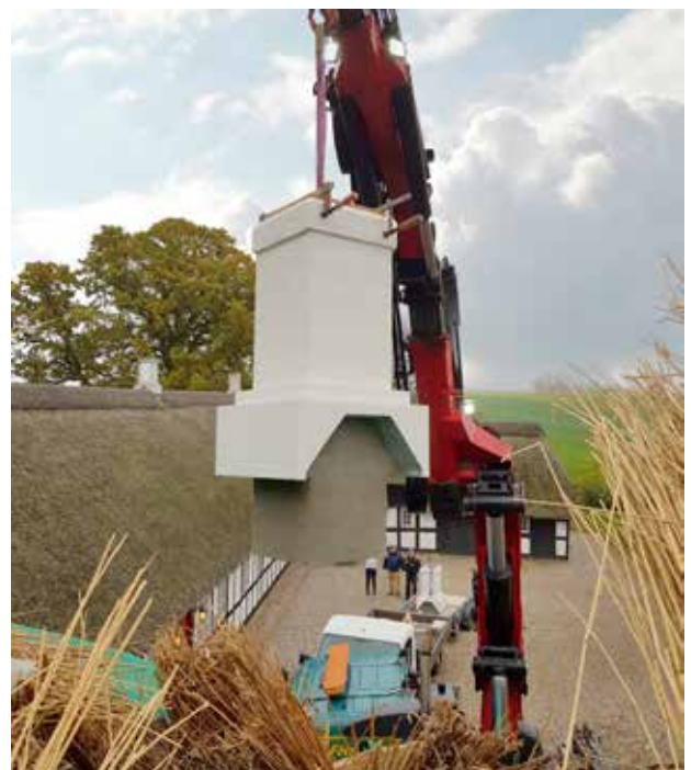
Foto 58 Opsætning af ny skorsten med udkrægning
