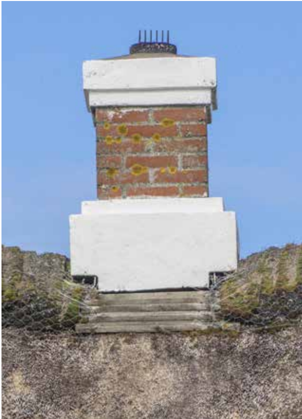
Foto 56 Skorsten med muret udkrægning
