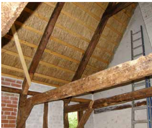
Foto 30 Brolag sikrer en pæn underside
