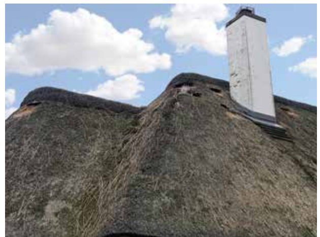
Foto 65 "Fugleskader"
