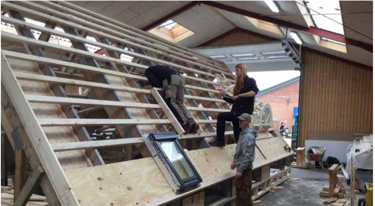
Foto 46 Tagkonstruktion lægget til stråtag
