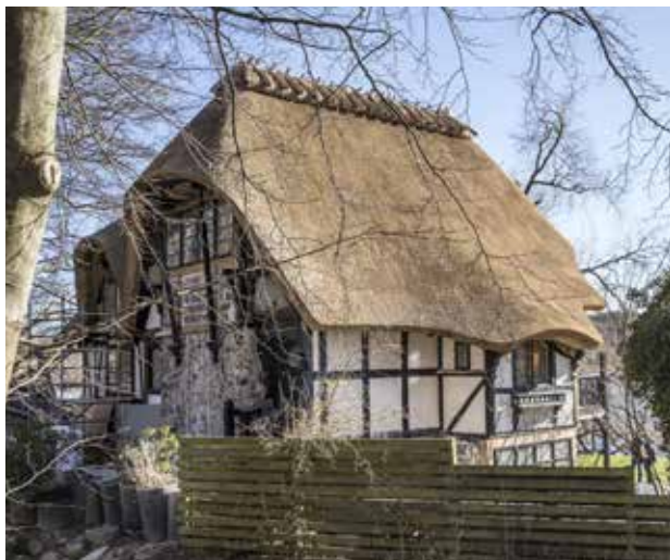
Foto 19 Stort hus – lange rør
