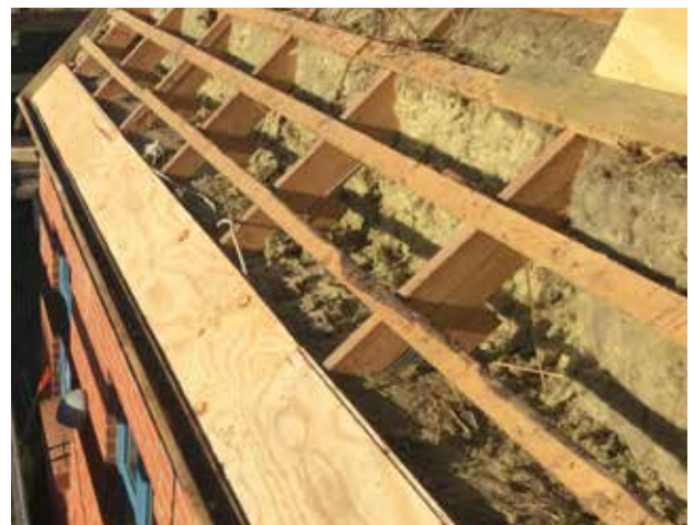
Foto 48 Vindstop ved tagfod
