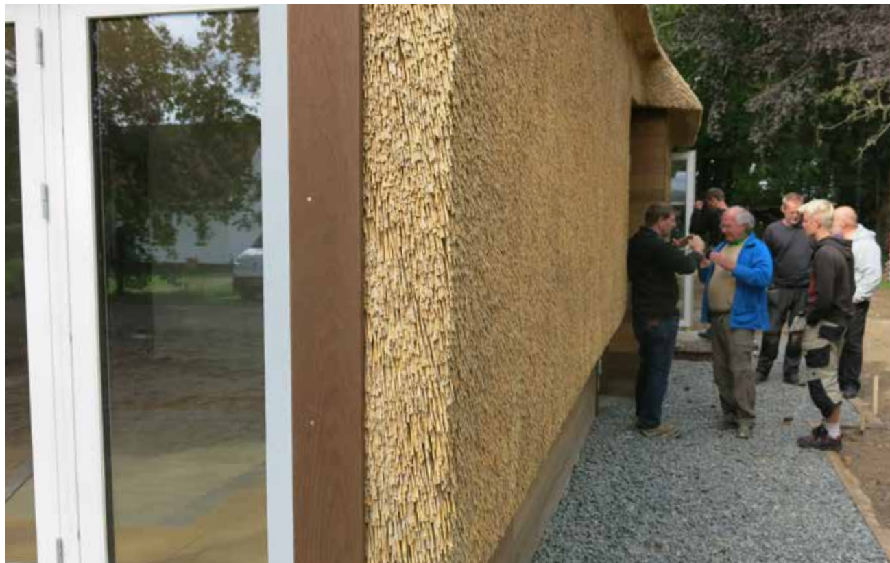
Foto 71 Lodret tækning – Det Åndbare Hus
