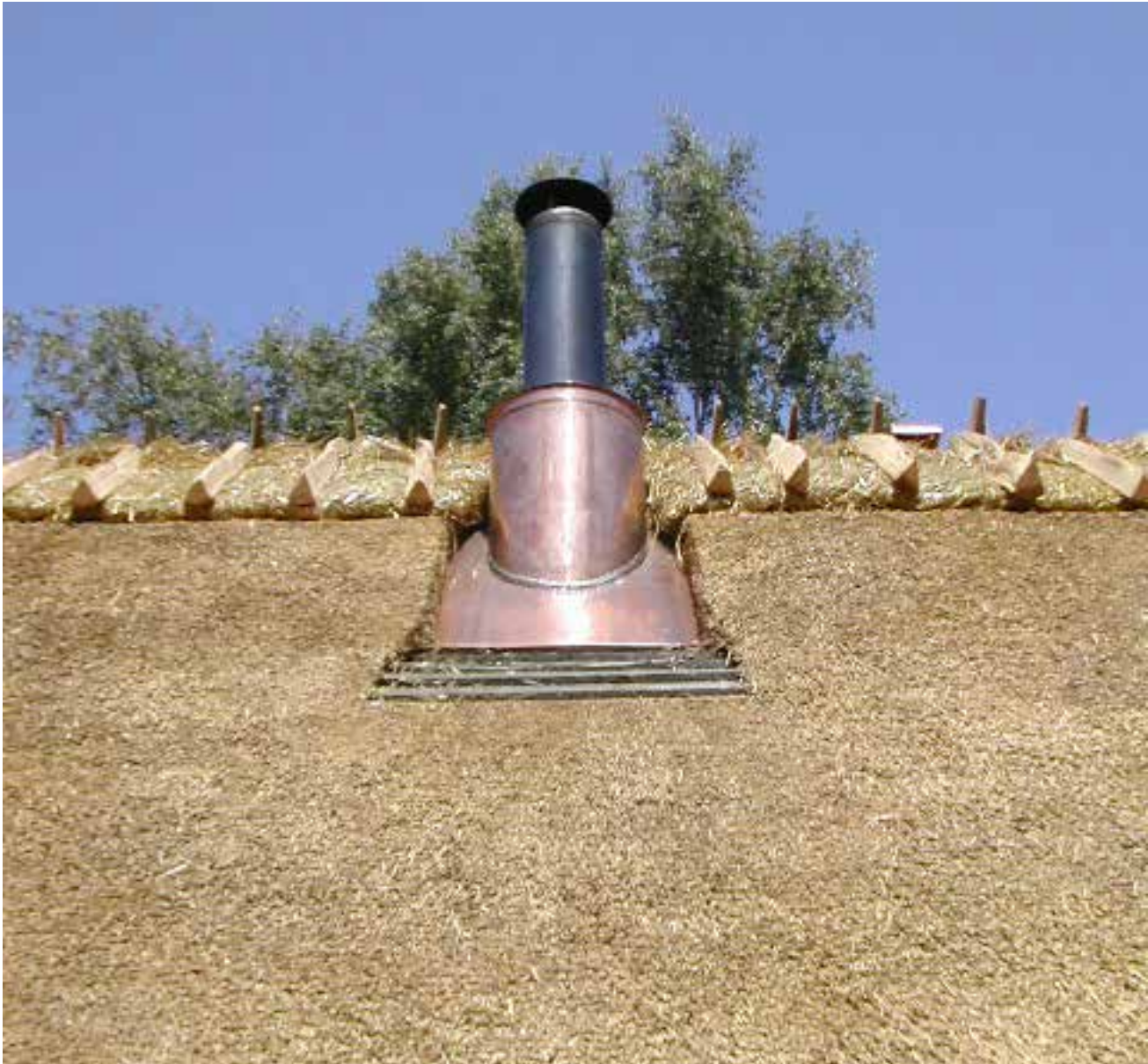
Foto 60 Kobberinddækket stålskorsten
