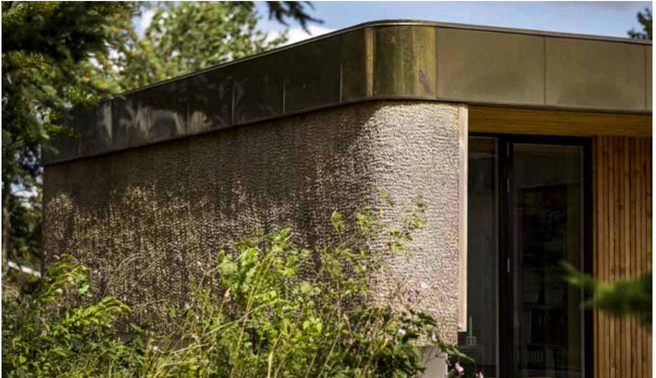
Foto 70 Tækning af lodret facade
