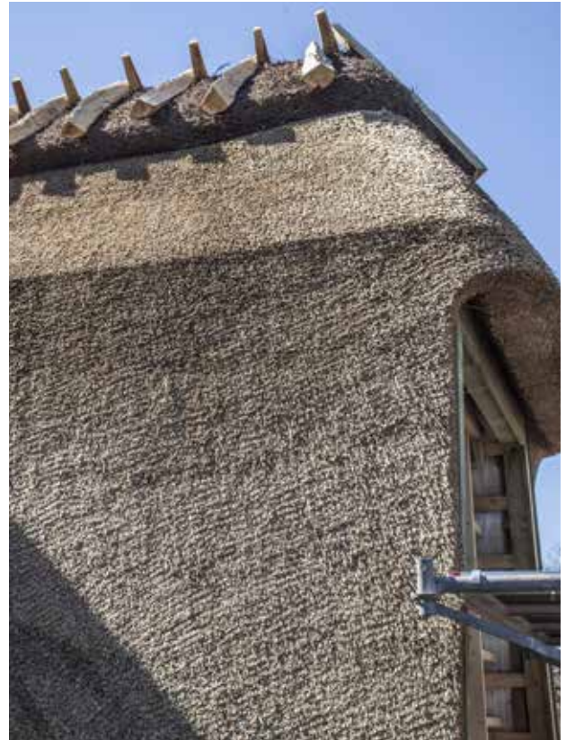
Foto 73 Tækning af mansardtag
