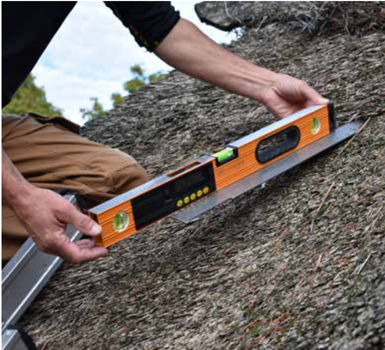
Foto 9 Måling af rørenes hældning
