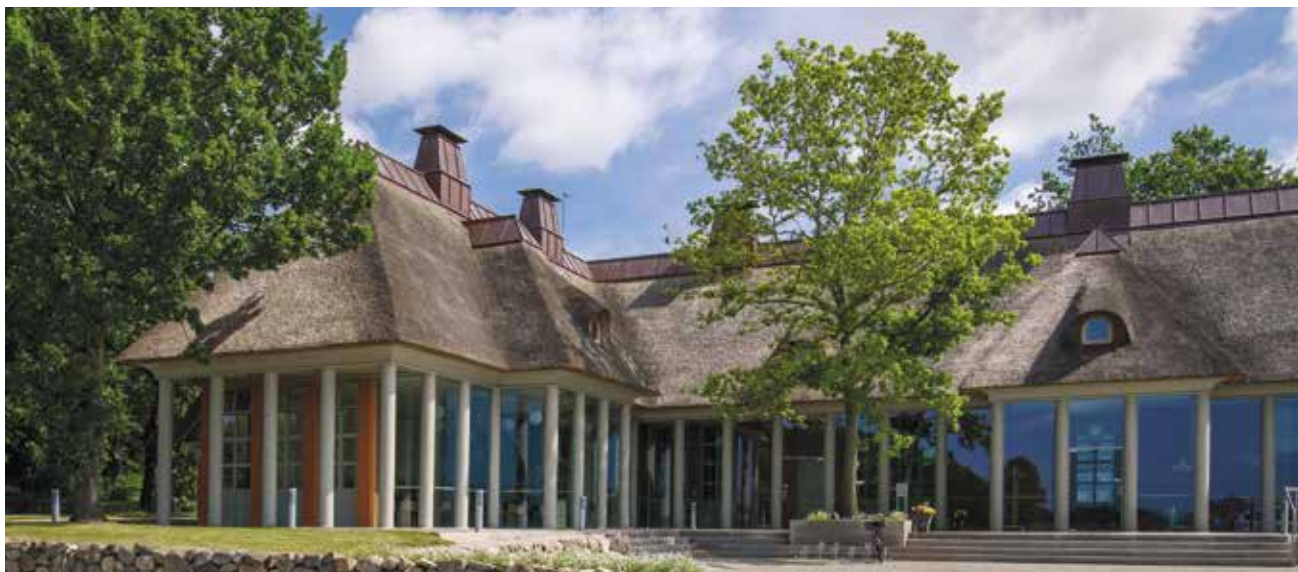
Foto 42 Fast kobberrygning
