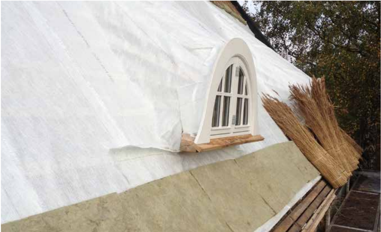
Foto 6 Brandsikring med godkendt glasfiberduk og kantisolering
