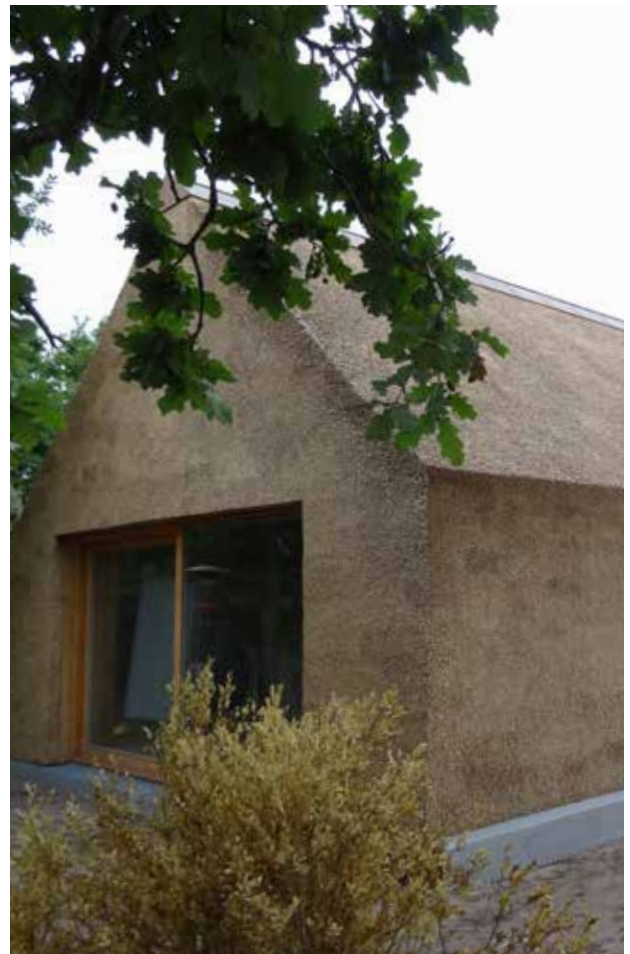
Foto 2 Tag og facade tækket ud i et
