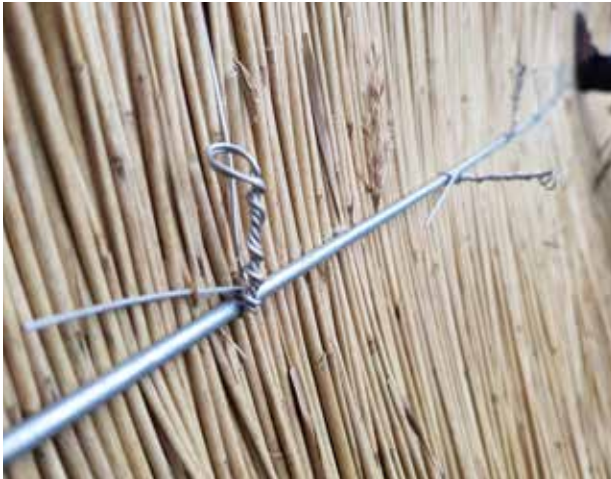
Foto 14 De snoede ender af tækkeskruerne skal lægges ned, ellers vil de blive synlige i mange år, inden taget er slidt op
