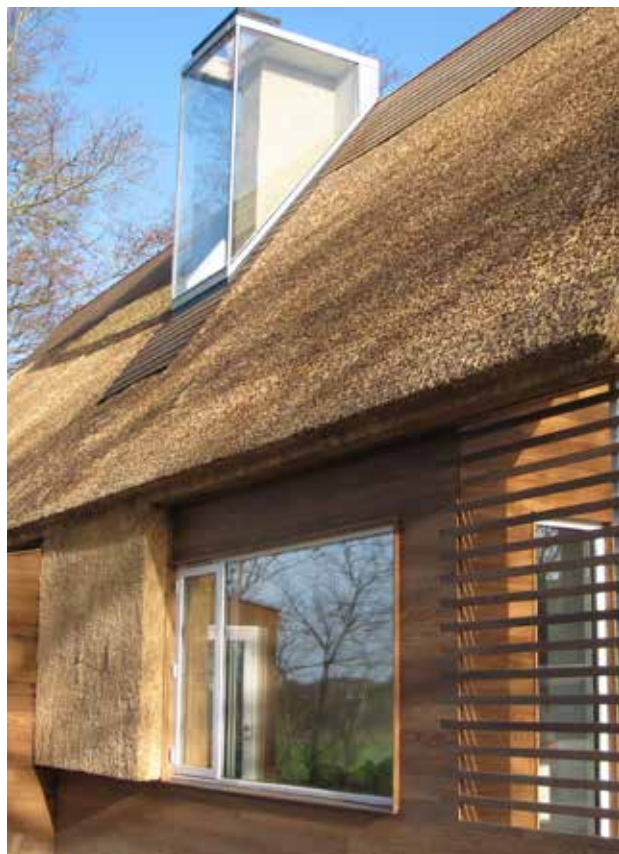
Foto 72 Lodret tækning – Det Åndbare Hus
