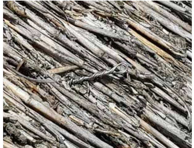
Foto 14 De snoede ender af tækkeskruerne skal lægges ned, ellers vil de blive synlige i mange år, inden taget er slidt op
