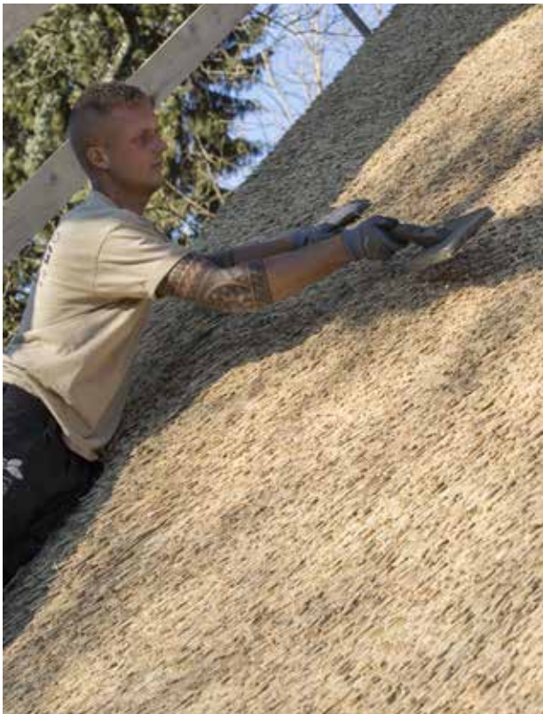
Foto 34 Tagfladen bankes på plads med en tækkeskovl
