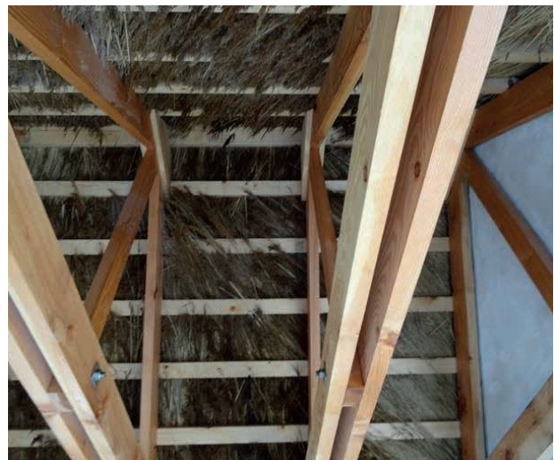
Foto 31 Uden brolag får man en "floffy" underside, der drysser
