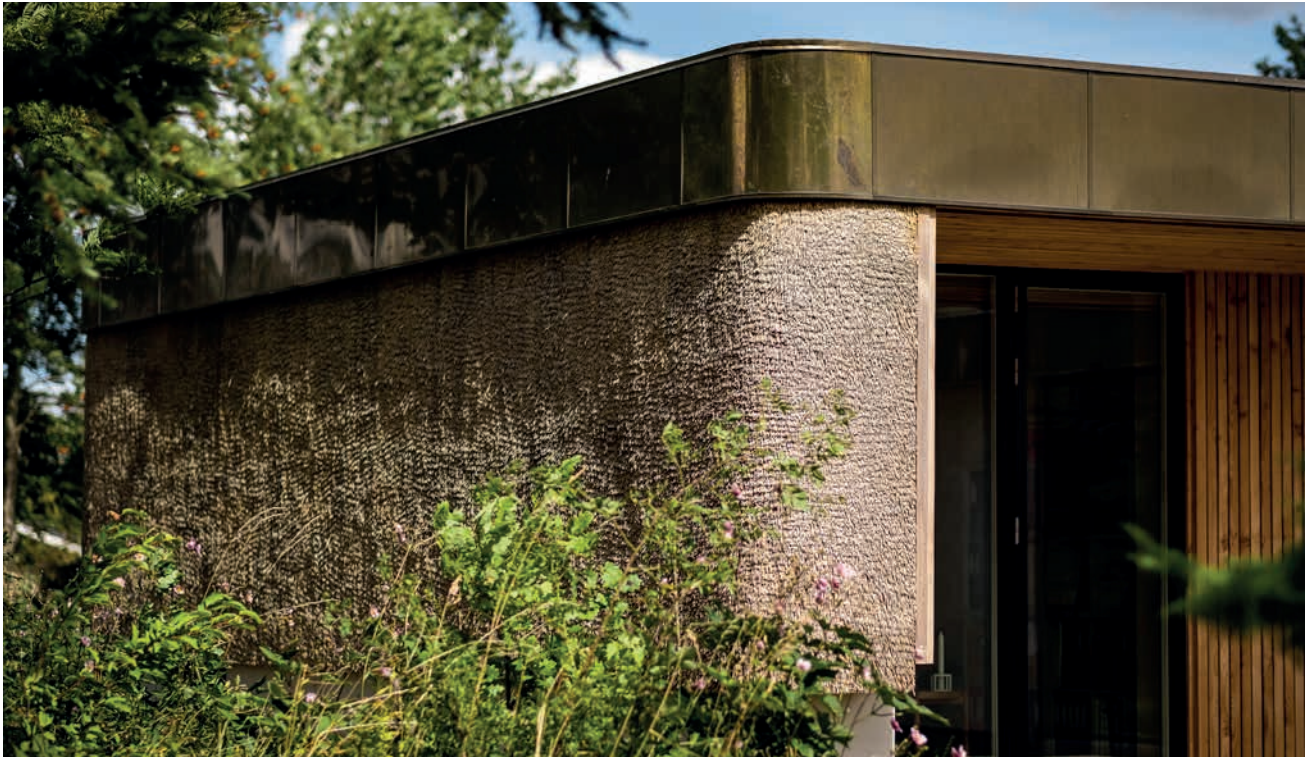
Foto 70 Tækning af lodret facade
