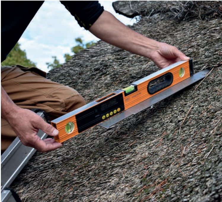
Foto 9 Måling af rørenes hældning
