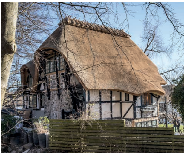
Foto 19 Stort hus – lange rør
