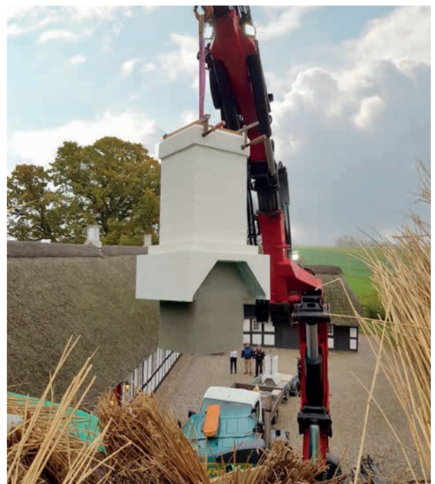
Foto 58 Opsætning af ny skorsten med udkrøgning
