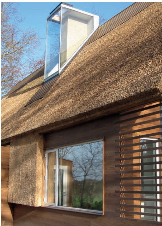
Foto 72 Lodret tækning – Det Åndbare Hus
