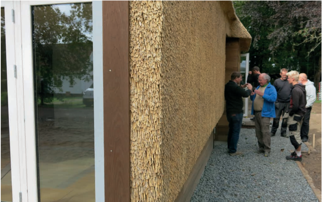
Foto 71 Lodret tækning – Det Åndbare Hus
