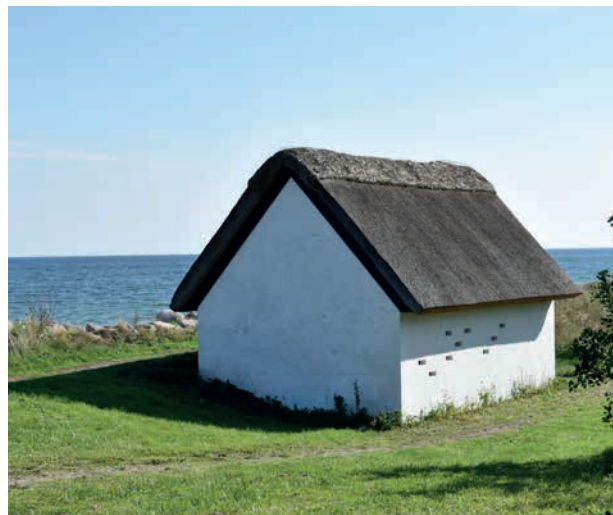
Foto 20 Lille hus – korte rør
