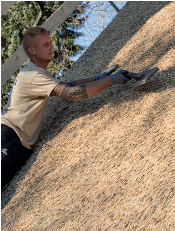
Foto 34 Tagfladen bankes på plads med en tækkeskovl
