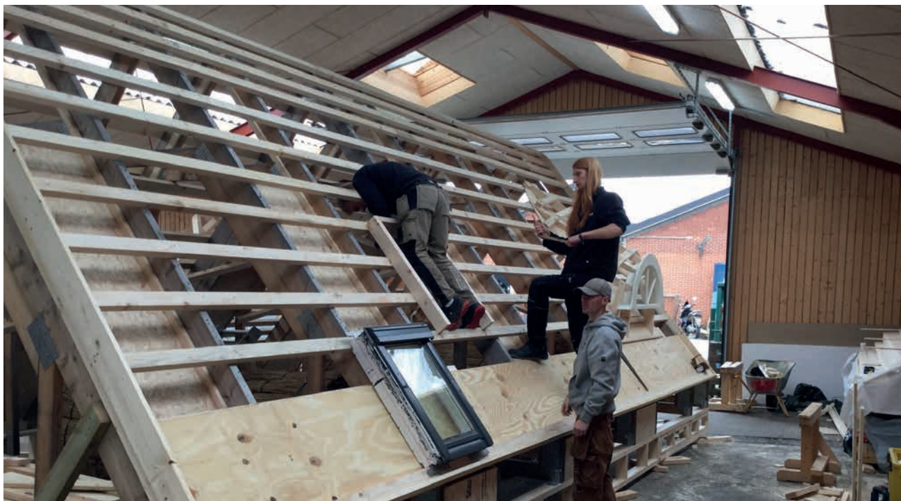
Foto 46 Tagkonstruktion lægtet til stråtag
