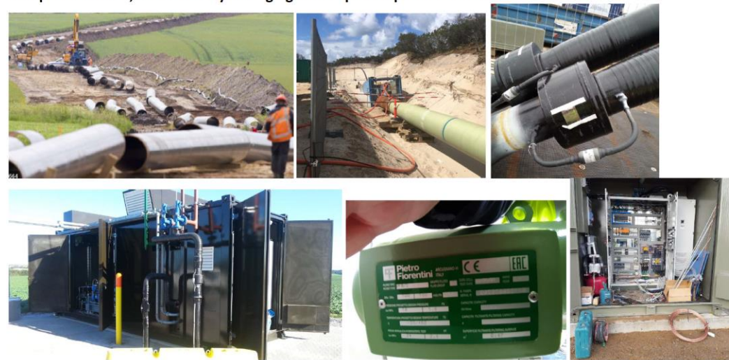
Baltic Pipe, styret underboring ved Vestkysten (HDD), isolerkobling Kompressorenhed, måler ved trykanlæg og eltavle på kompressorstation
