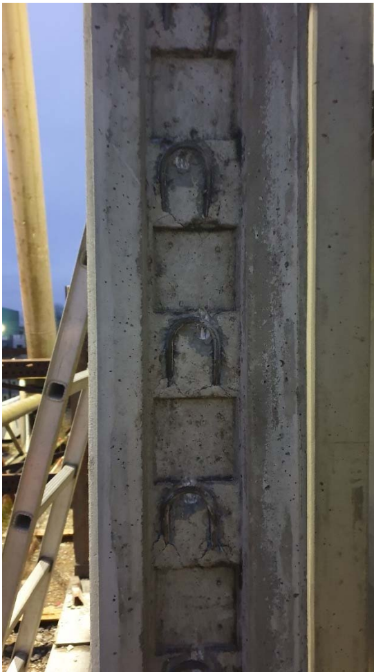
Figur 4-1 Illustration af rundjernsbøjler i kanten af betonelement.
